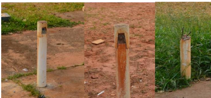
FOTO 10 – pontos de torneira a serem restaurados.
