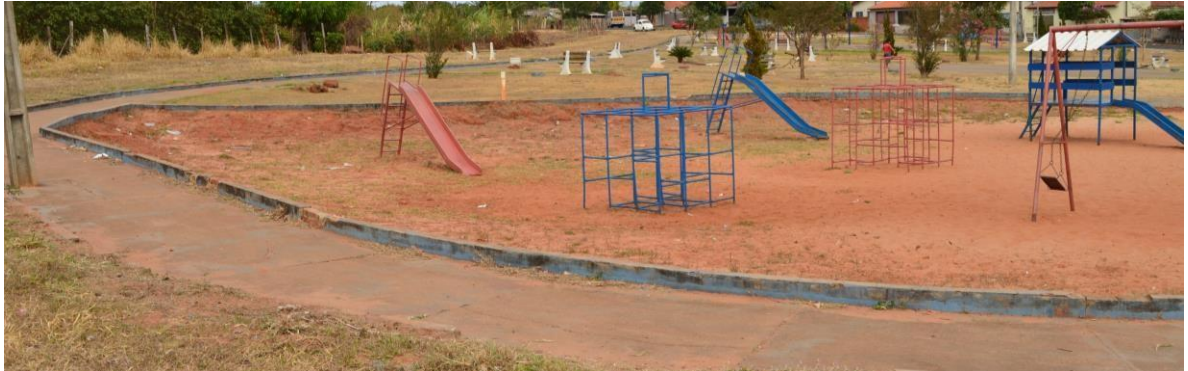
FOTO 08 – tanque de areia
