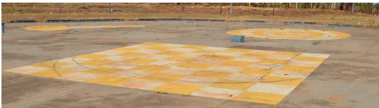
FOTO 13 – pintura de caracol, amarelinha e xadrez - serão restauradas
