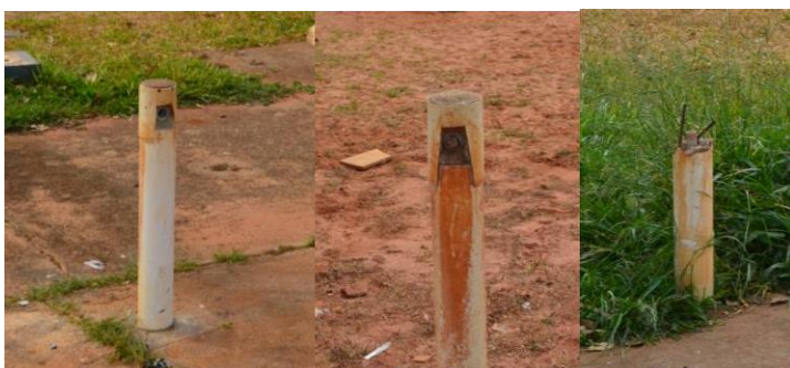
FOTO 10 – pontos de torneira a serem restaurados.
