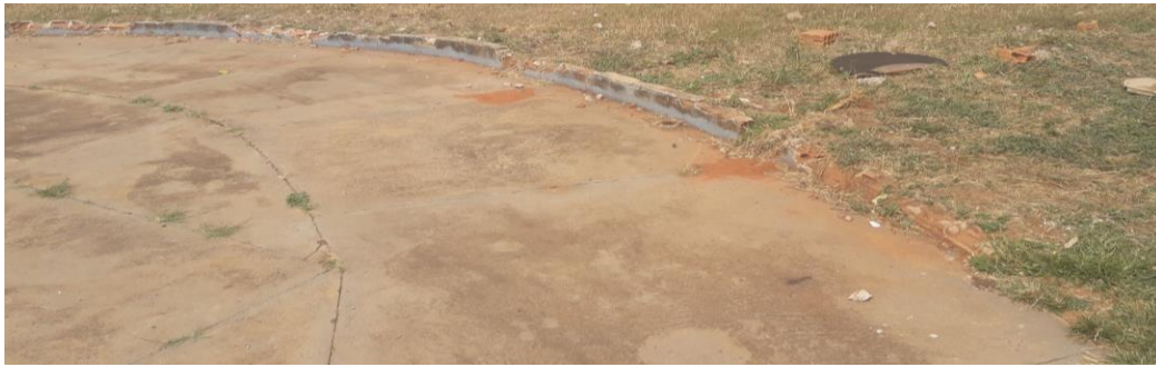
FOTO 04 – Local a ser executado a alvenaria/guias - contorno da praça
