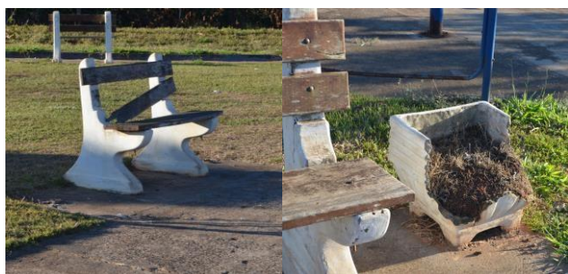
FOTO 02 – Bancos e vasos – serão removidos sem reaproveitamento
