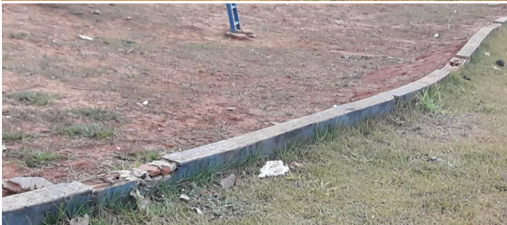
FOTO 06 – Mureta/parque/areia – serão restauradas/pintadas
