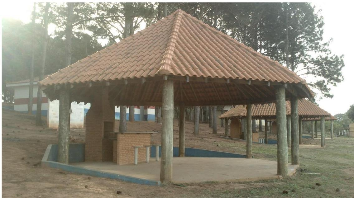
As muretas existentes receberão massa única em argamassa, traço 1:2:8, preparo mecânico com betoneira 400 litros, espessura de 20 mm, executada com taliscas e pintura com tinta acrílica antimoho. Além das muretas, as bancadas com tijolo à vista dos quiosques também receberão massa única, além de pintura em tinta acrílica antimoho.
