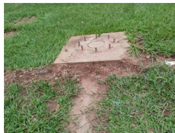
Base de Concreto
