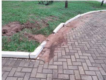
Meio fio existente
