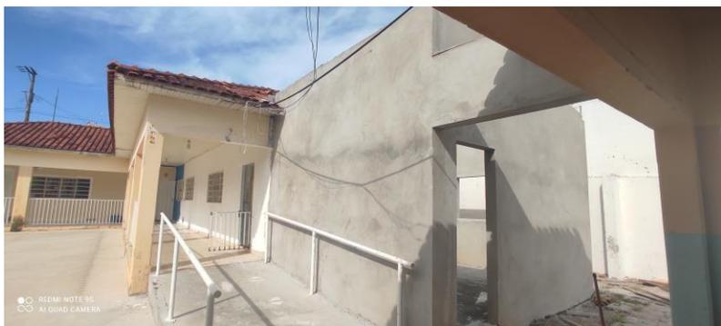
Esta sala, ao lado do depósito, não foi incluída na reforma. Devido a demolição do beiral para fazer a cobertura do depósito e a não instalação da calha, o piso foi danificado com água da chuva. Agora será necessário a reposição.
