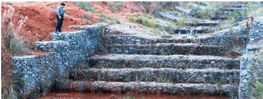
Ilustração 8.3 – Dispositivo de amortecimento em degraus de gabião
