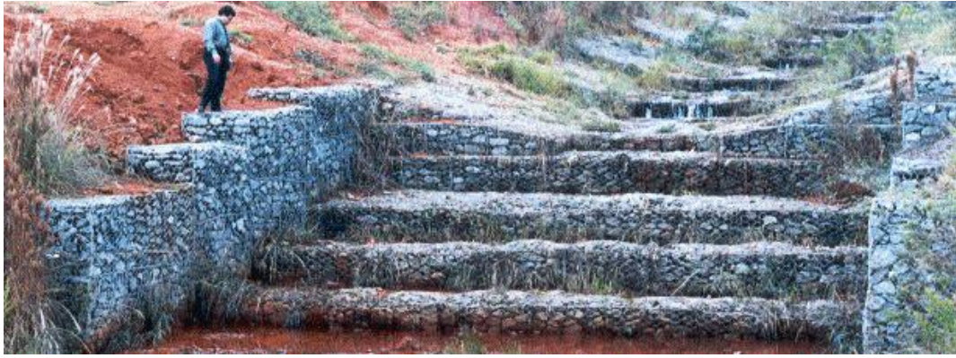
Ilustração 8.10 – Dispositivo de amortecimento em degraus de gabião
